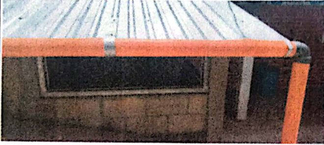
Foto 1: Techo instalado del mejoramiento tipo pórtico
